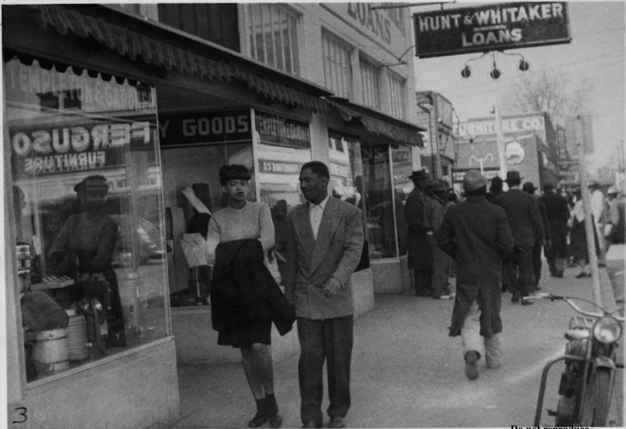
3 Looking N. to Amite st
